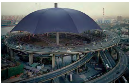
Сооружение в форме зонта над автострадой в Ганьсу
