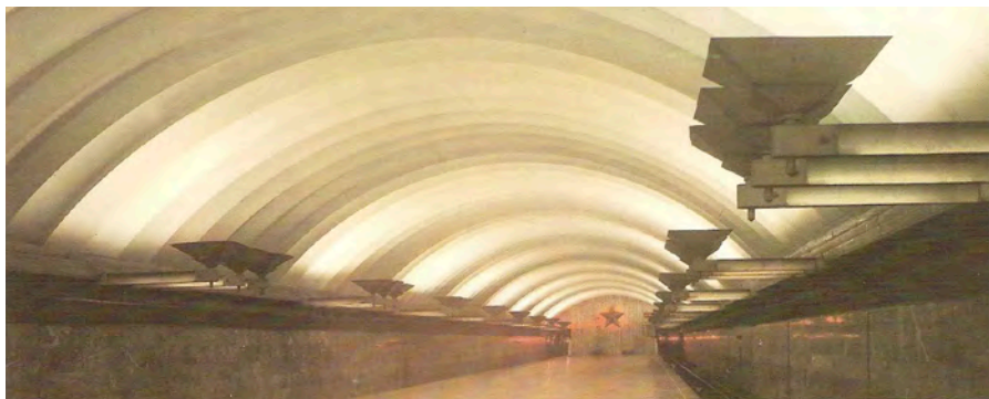
Рис. 1. Станция Площадь Мужества, г. Санкт-Петербург.
