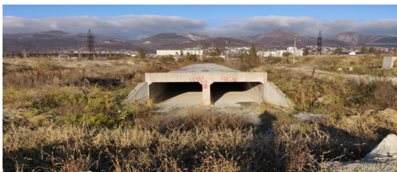
Рис. 3. Общий вид трубы со стороны выходного оголовка.
