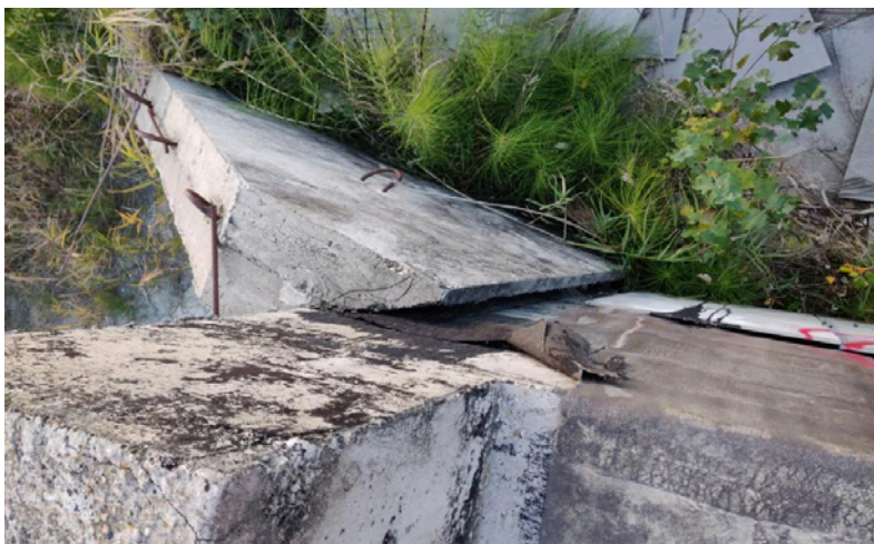
Рис. 6. Сопряжение открьлка с телом трубы.
